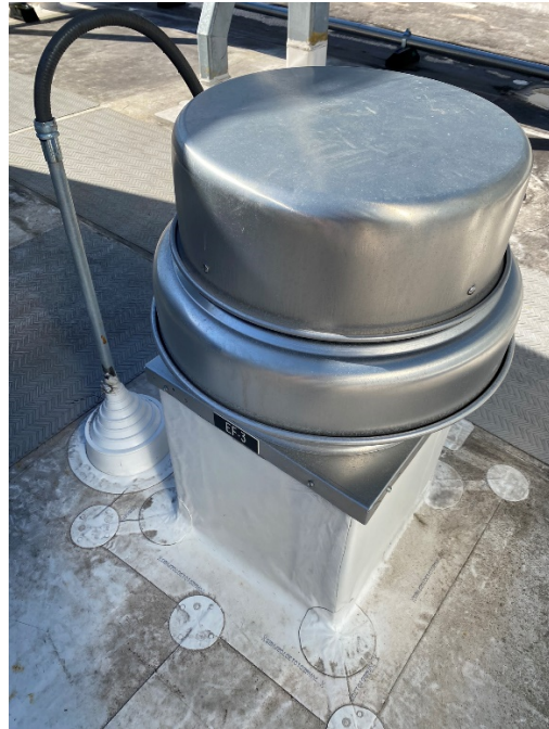
C-14: Exhaust Fan EF-3
